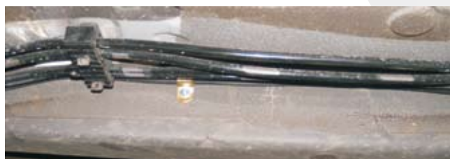
Rys. 8 Przewód gazowy zamontowany na blaszki montażowe
